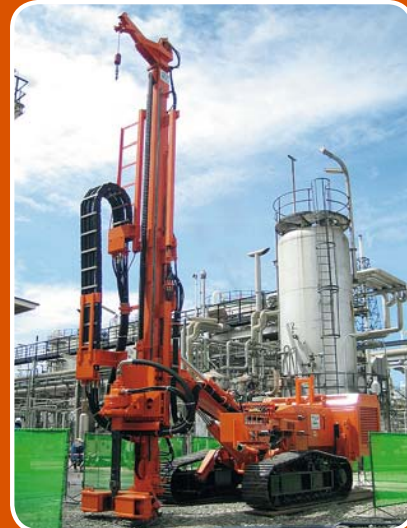
Brunei - Micropiling with Drag Bit \phi 229.0\text{mm} Brunei - Mikropfähle mit Stufenmeißel \phi 229.0\text{mm}
