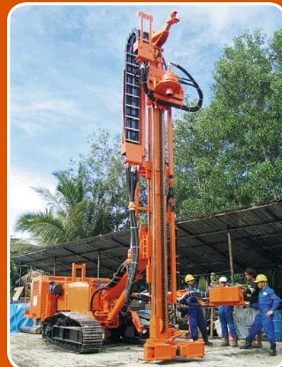
Greece - Micropiling with Tricon Bit \phi 127.0\text{mm} Griechenland - Mikropfähle mit Rollenmeißel \phi 127.0\text{mm}
